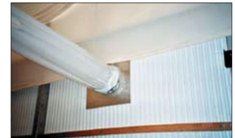
Warme Luft wird über einen Schlauch bis zu 100 m im Zelt optimal verteilt
